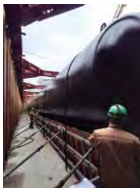
地下に設置された貯水槽
