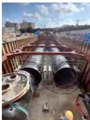
地下に設置された貯水槽
